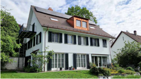
Einliegerwohnung im Dachgeschoss, Solothurn
